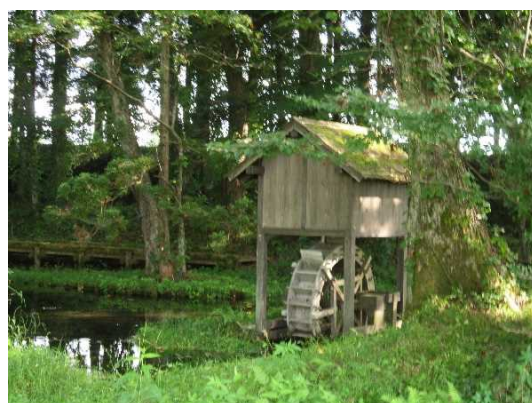
写真7 湧水を利用した水車発電
