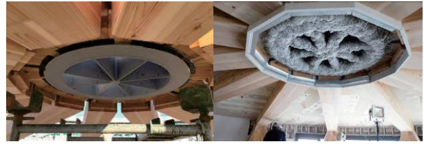
図 5 S 造リングの耐火被覆 (左：被覆前、右：被覆後)
