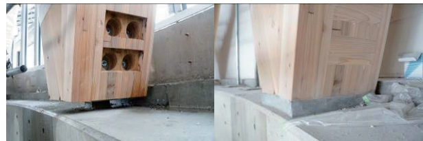
図 6 柱脚部分の処置 (左：固定時、右：処置後)
