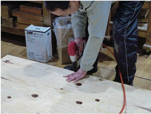
写真 10 タッカーにより薄物合板を留める
