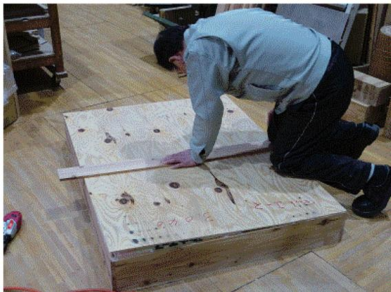
写真 12 薄物合板で反対面を貼る
