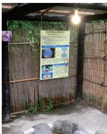
図7 熱電発電システムによる照明とポスター
