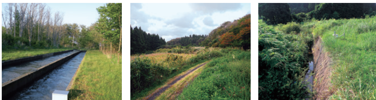
図8-2 調査地区の状況写真。
