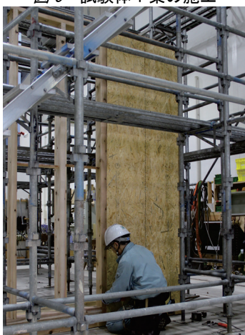
図6 試験体1耐力壁面材の施工
