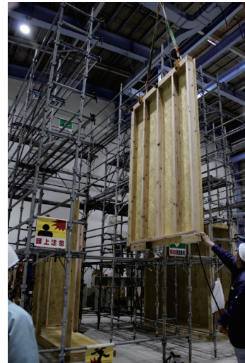
図9 試験体2パネル吊り上げ
