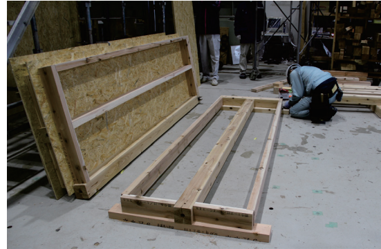
図7 試験体2パネル製作(軸組)
