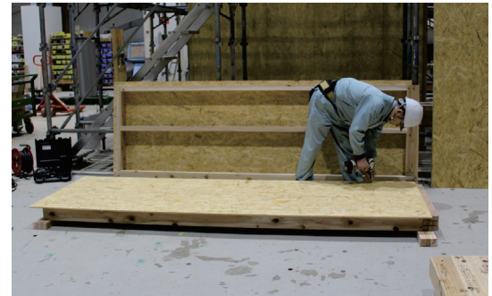
図8 試験体2パネル製作(耐力壁面材留め付け)
