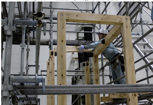
図5 試験体1梁の施工
