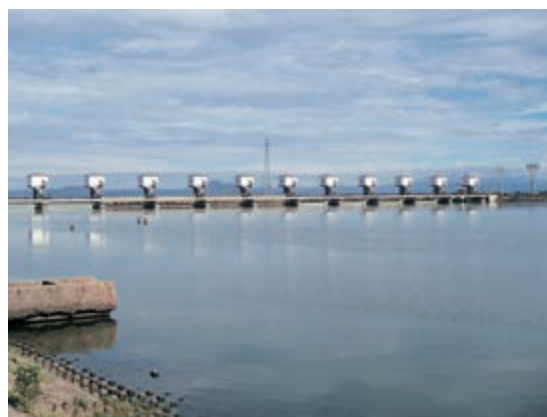
図4 a 八郎潟干拓地防潮水門、湖水位の低下で水位差と流速が低下した様子
