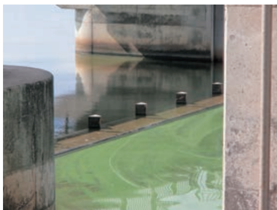
図4 a 八郎潟干拓地防潮水門、湖水位の低下で水位差と流速が低下した様子
