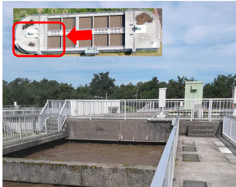
図4-11 無終端水路における縦軸型攪拌機がコンクリート打設面で覆われている様子
