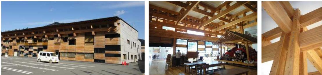
写真3 木組みを応用した高知県梶原町庁舎（左）における架構（中央）、接合詳細（右）
