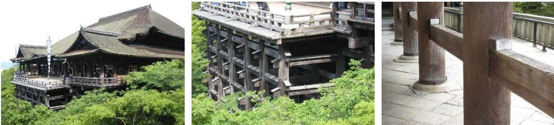
写真1 清水寺（左）における貫構造の舞台（中央）、回廊の柱（右）
