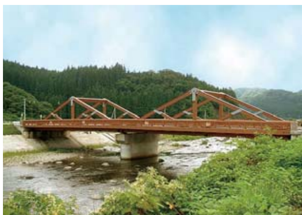
写真2 国内最大級の木橋・坊中橋（藤里町）。
