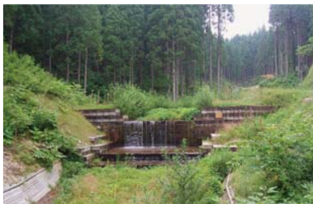
写真1 木製治山ダム（五城目町）。
