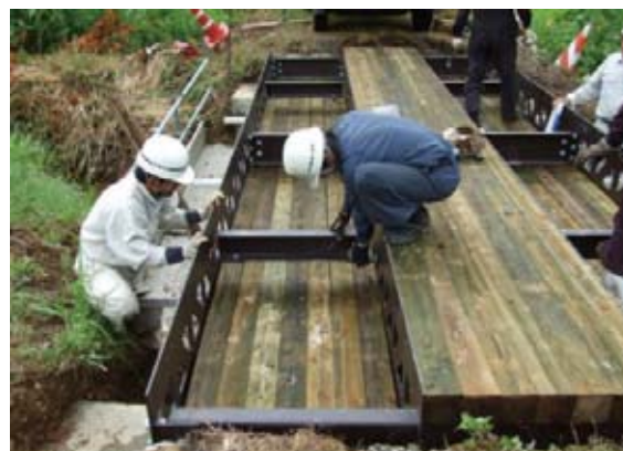
写真 14 角材の敷設作業.
