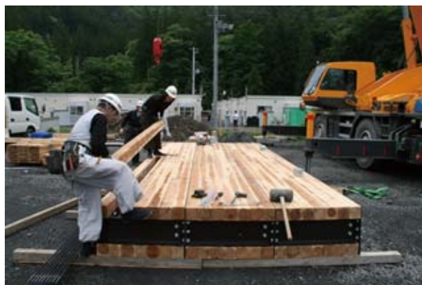
写真 10 岩手県大槌町での仮設橋の組立作業。
