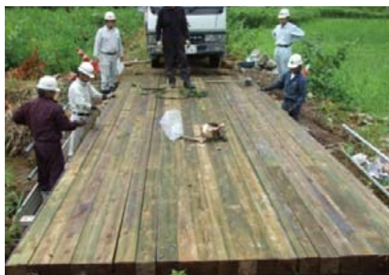
写真 15 敷設作業完了と PC 鋼棒の挿入.
