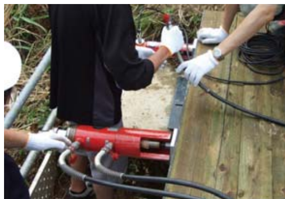
写真 16 油圧ジャッキによる PC 鋼棒の緊張作業.
