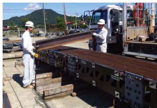
写真20 雪荷重を想定した歩道橋の載荷試験.
