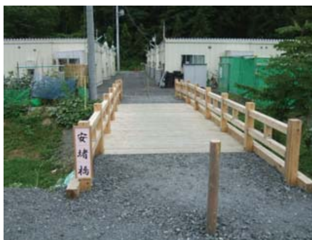
写真 11 岩手県大槌町での仮設橋（橋長 6.3m）。
