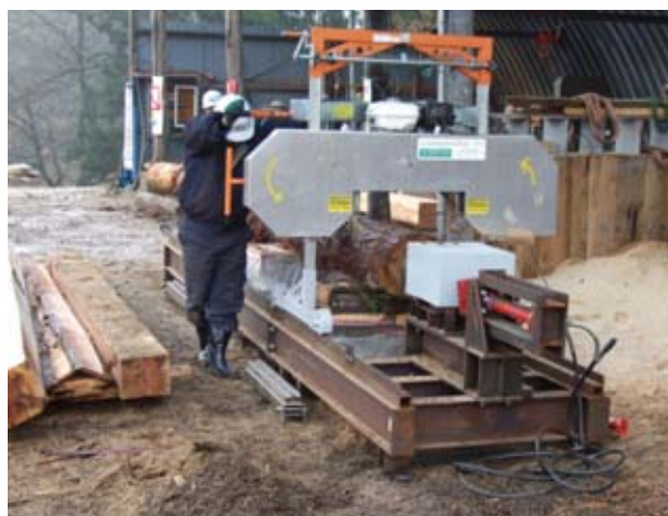
写真5 木製ダム部材(250×300mm)の製材。
