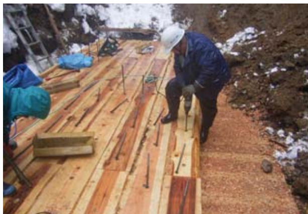
写真6 木製ダムの組立.
