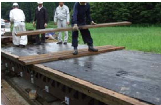
写真 17 防水シートと床板の敷設.
