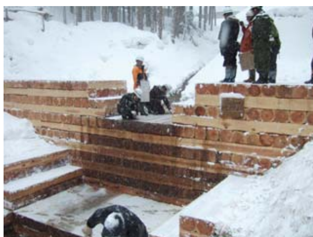
写真7 完成した木製治山ダム（鹿角市）.
