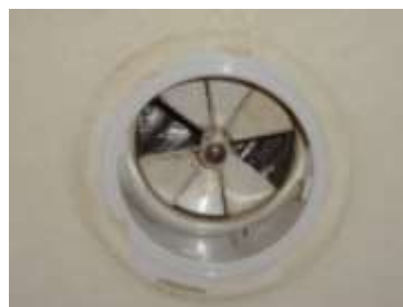
写真5 1階排気口の開口面積可変装置 (B邸)。
