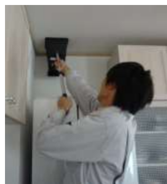
写真1 給排気口の風量測定。
