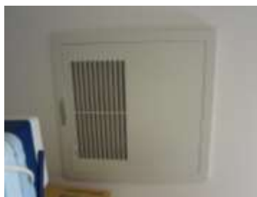
写真7 排気口 (K 邸, 設置位置: 天井面).
