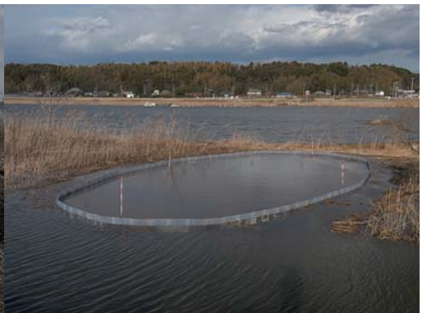
写真12 大雨増水時のザリガニ侵入防止壁 外周の波板囲いは、内部から土嚢袋で増水時の水圧に耐える構造とした為、台風後増水時にもザリガニ侵入を阻止。
