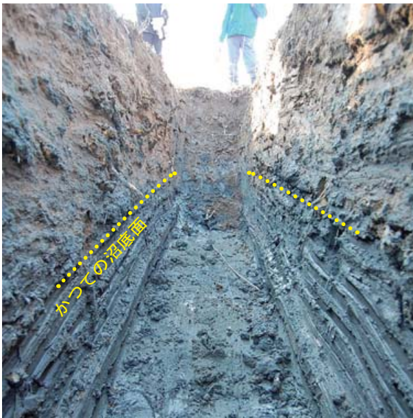
写真3 かつての沼底下まで掘削した状態。 砂層でなくシルト層の沼底面を探す。
