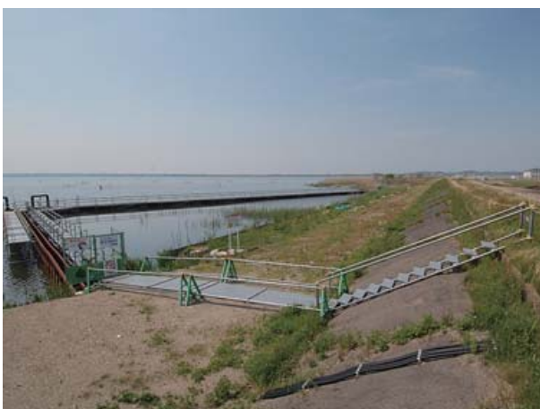
写真 17 鋼製矢板を用いて沿岸の一部を囲い 込み、ポンプで水位を下げた。内部 の底泥は排除し、埋土種子を含む土 壤を撒きだした。
