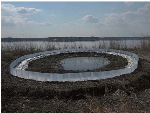
写真11 高水敷掘削による池創出 抽水植物に覆われた高水敷を掘削し、土壌シードバンクからの発芽を期待。周囲の波板はザリガニ侵入防止用。
