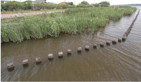
写真 19 木杭・板壁で波浪緩衝護岸を整備 手賀沼岸への波浪緩衝のためアシや ヒメガマなど抽水植物を繁茂させる 浅瀬を木杭と板で整備している。
