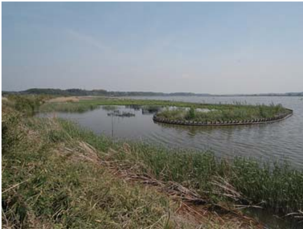
写真 15 緩傾斜護岸法を逆勾配で適用 風当たりが強く波浪が高い地点のため 木杭で湾処をつくり、内部に沈水 植物の繁茂域を期待した。
