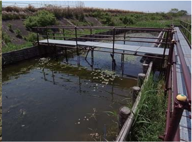
写真 14 見学用の足場と手すりを整備 高水敷の池で最も沈水植物が豊富に 見られた池を再整備して見学用途に 使えるよう維持管理している。
