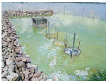
写真7 アオコが多量集積・腐敗 (消波堤No6、8月27日)
