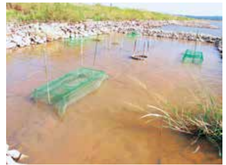
写真17 牡丹川消波堤D-1の全景(2013.10.14)
