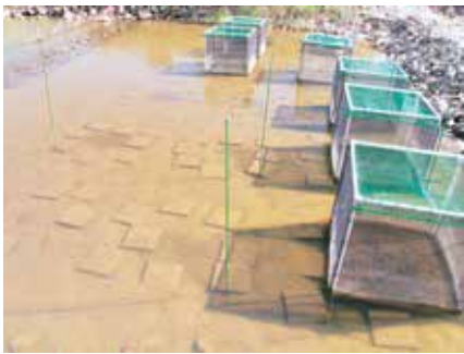
写真12 消波堤No6内への食害防止柵の設置(右、10月14日)
