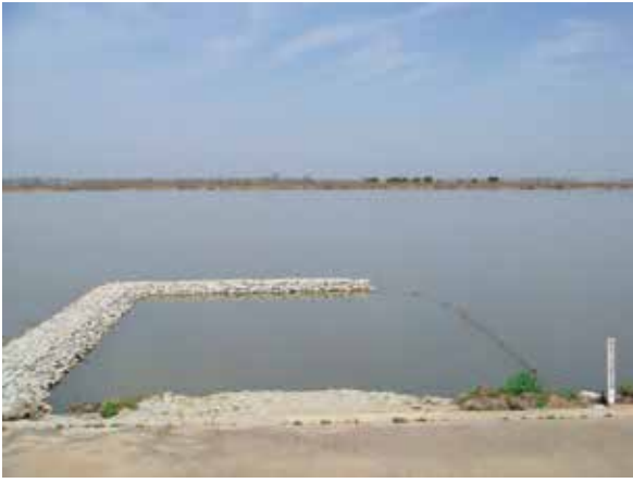
写真1 建設直後の夜叉袋消波堤No9 (2010. 5. 18) —沈水植物再生ゾーン、約15×9 m—
