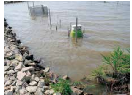
写真5 沈水植物等の移植完了時の様子 (消波堤No6、2012. 6. 30)
