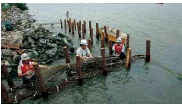
写真3 消波堤の粗朶を詰める作業
