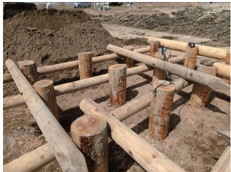
写真 15 井桁工法.
