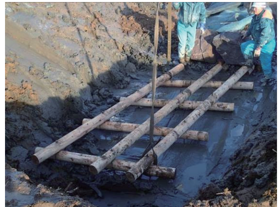
写真7 地組した胴木・横木の設置状況。
