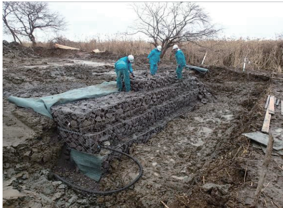
写真9 フトン籠の設置。
