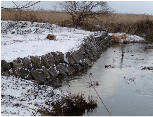
写真10 完成した水路護岸。
