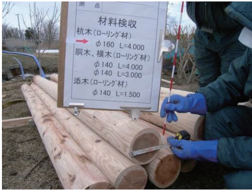
写真2 丸棒加工した木杭基礎部材.
