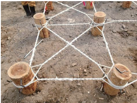
写真 14 パイルネット工法.
