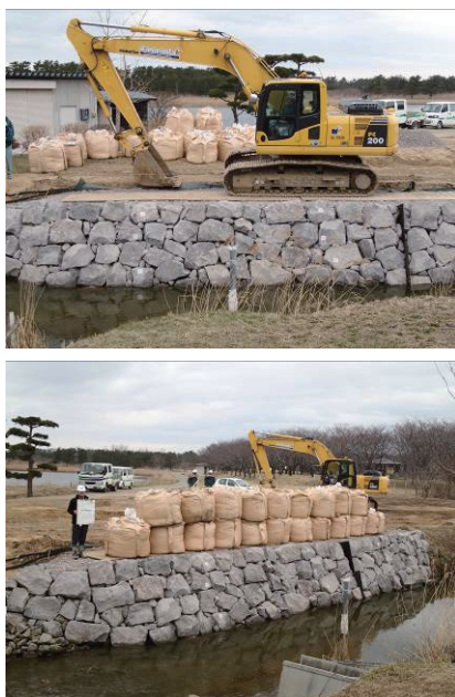
写真11 載荷試験（上：重機、下：重り）。
