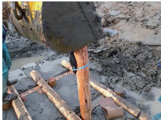
写真8 木杭の打設状況。
