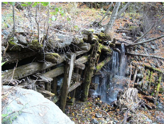
写真 1.11 流沢木製床固工
