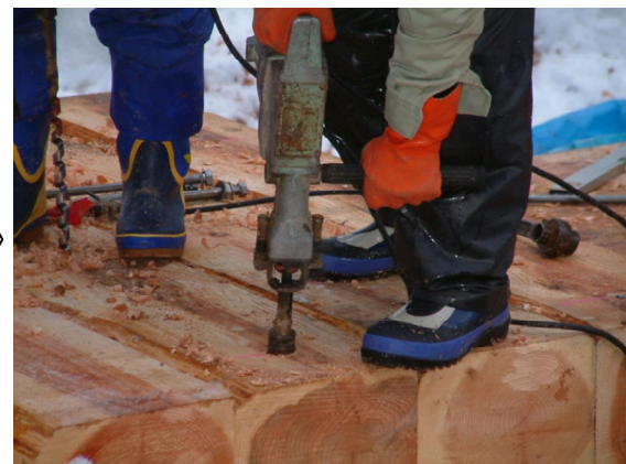
④インパクトレンチでラグスクリューの締め付け
