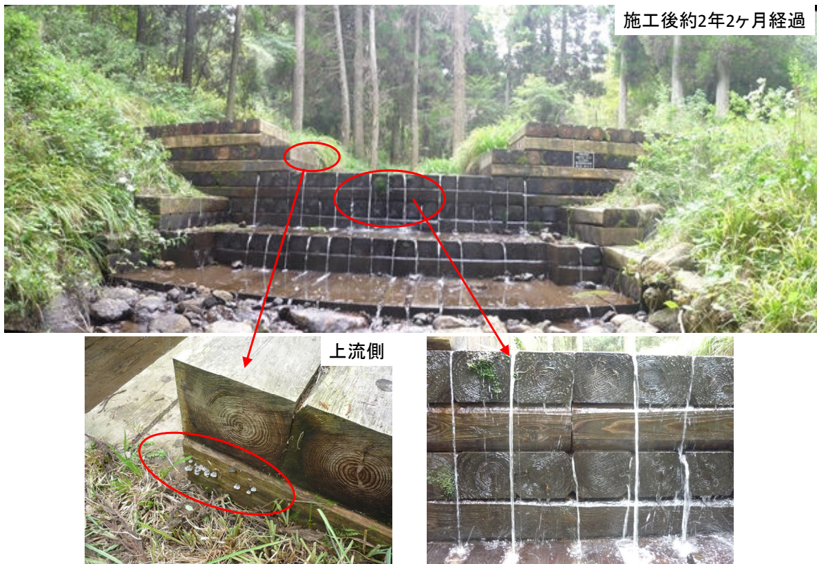
写真 3.10 現地状況（芹原 No.3、経過年数 2.2 年）
