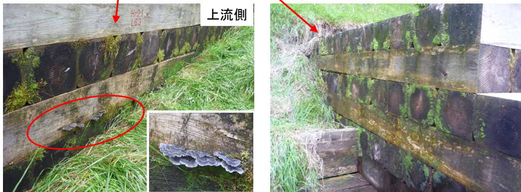
写真 3.12 現地状況（芹原 No.5、経過年数 2.2 年）
