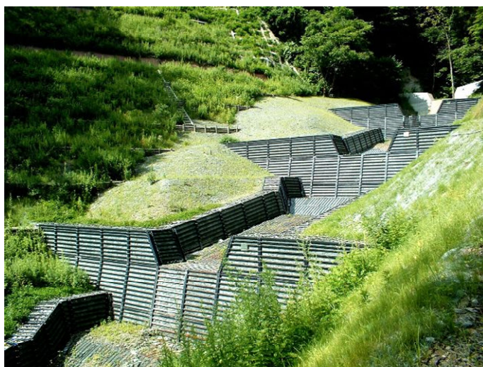
写真 1.8 鋼製治山ダム（提供：日鐵住金建材株式会社）
