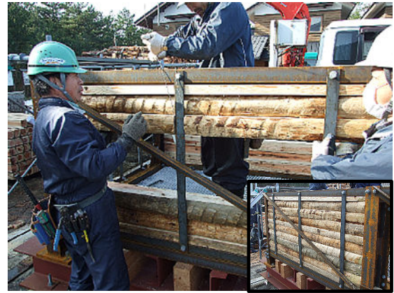
②鋼材の隙間に木材を落とし込み、壁を作る
