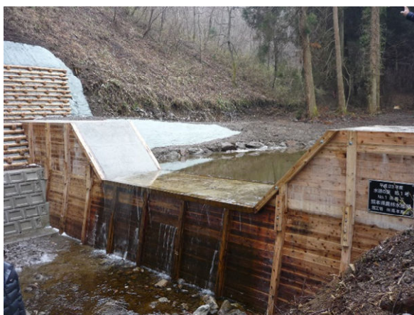
(a) 型枠残存タイプ（型枠あり）
