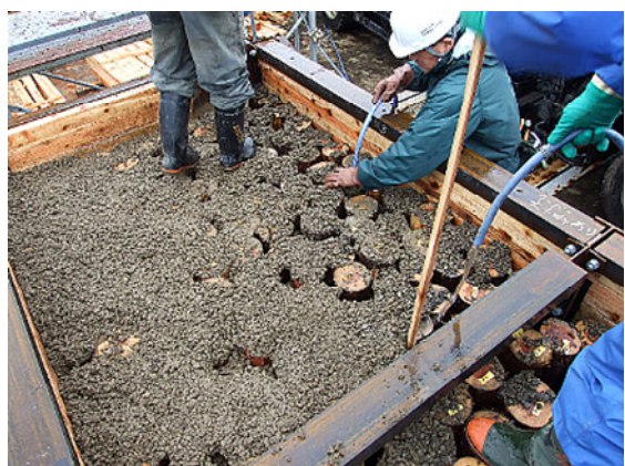
④隙間に砂利を投入し充填する
