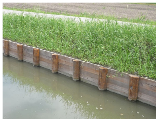
写真 1.2 用水路護岸木柵工
