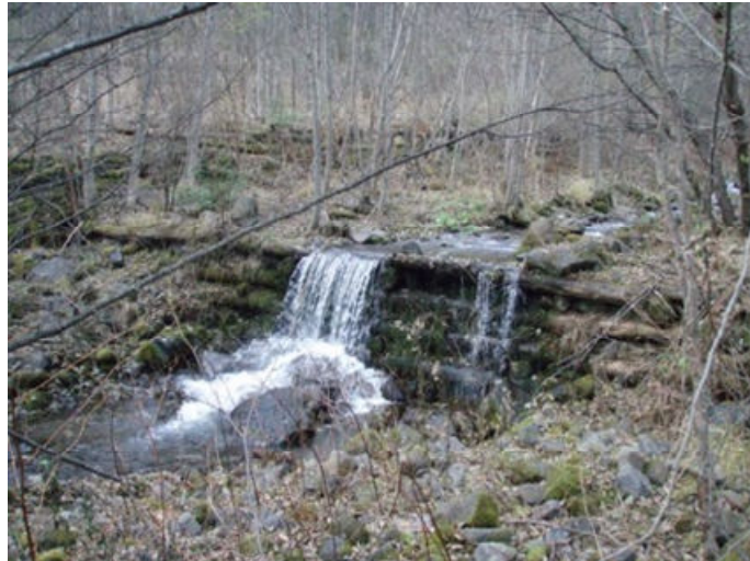
写真 1.10 御岳濁沢木製床固工
