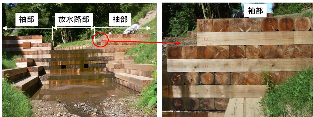
写真 3.4 現地の状況（小坪沢 No.1、経過年数 1.0 年）
