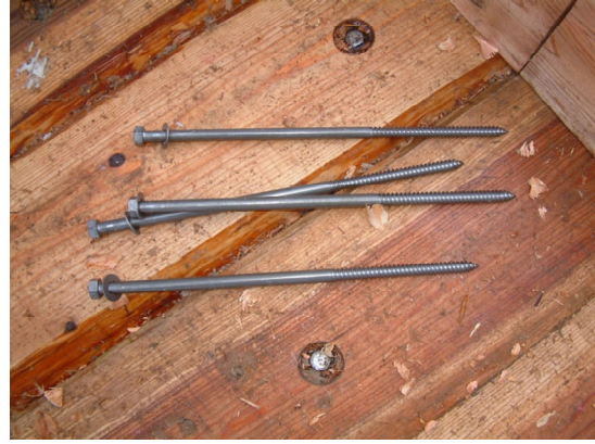
写真 1.14 施工状況と接合具（ラグスクリュー）
