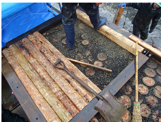
⑤中詰め材が流出しないよう、天井に木材を敷き詰める
