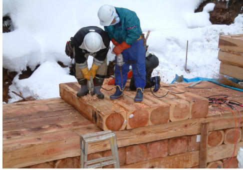
写真 2.2 オールウッド型木製治山ダムの施工状況（接合具の打ち込み）
