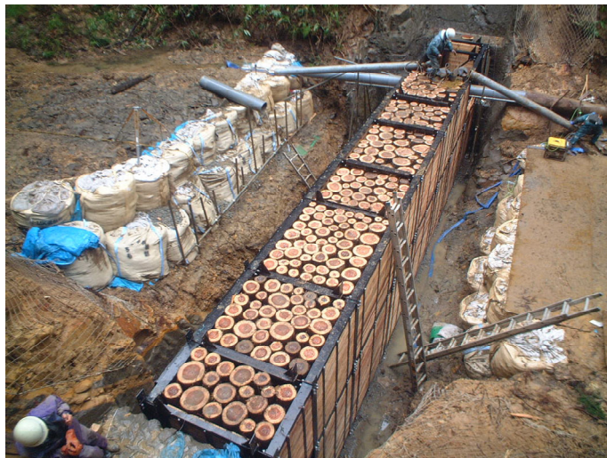
写真 1.17 皮付き間伐材の投入状況
