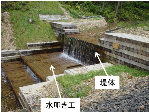
写真 4.1 オールウッド型木製治山ダム
