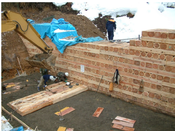
⑤①→③→④を繰り返す、所定の 高さまで積み上げる
