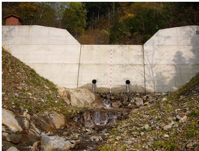
写真 1.7 コンクリート製治山ダム
