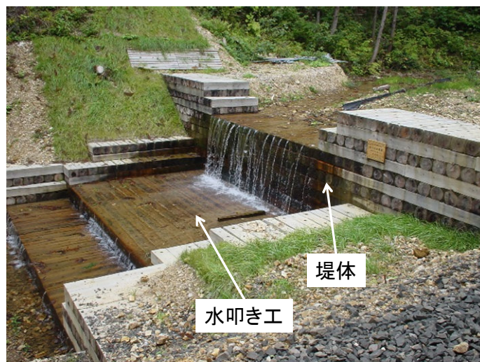
写真 1.25 オールウッド型木製治山ダムの水叩き工
