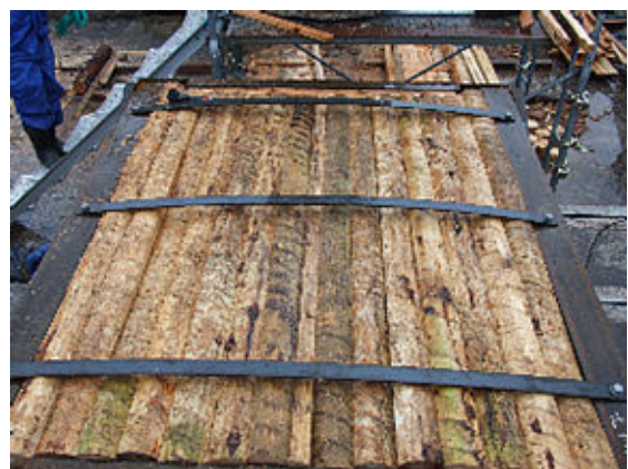
⑥鋼板で固定して完成
