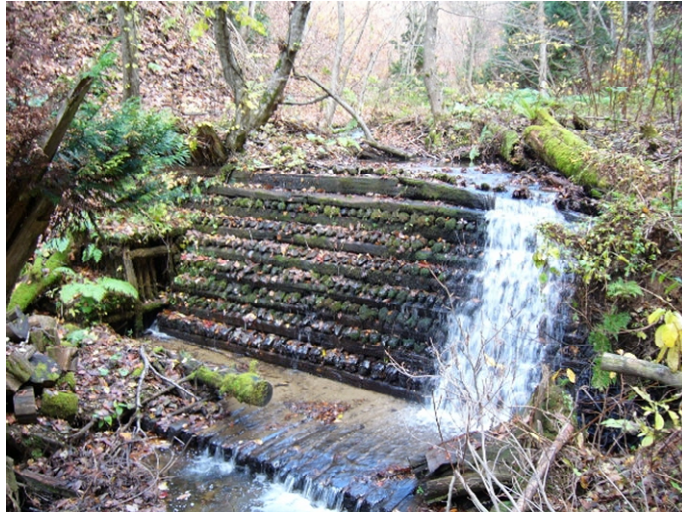
写真 1.9 坪毛沢木製床固工（昭和32年施工）
