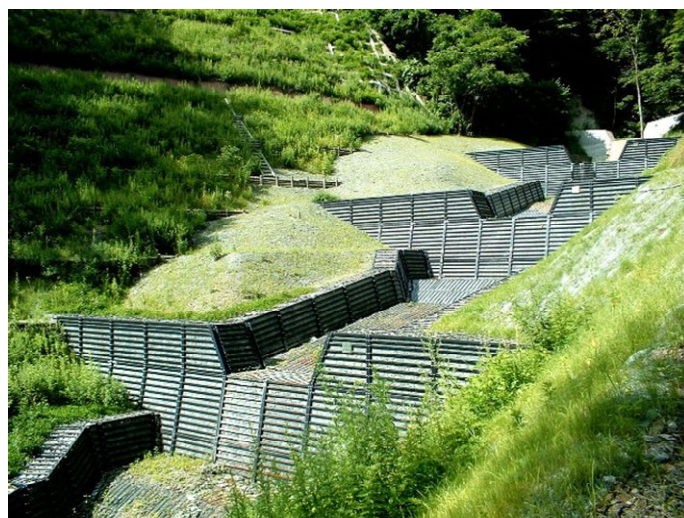
写真 1.9 鋼製治山ダム（再掲）
