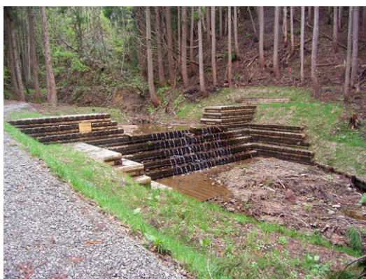
写真 1.6 変形ラムダ型木製治山ダム
