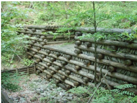
写真 1.5 枠ダム型木製治山ダム
