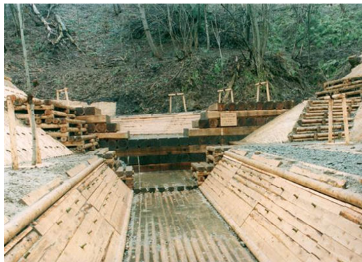
写真 1.13 第1号のオールウッド型木製治山ダム (槐 さい 岱 かち 道 たい 下 みち No.2)
