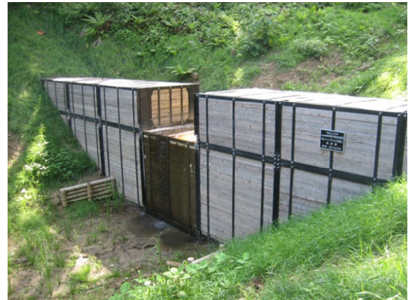
写真 4.2 ハイブリッド型木製治山ダム
