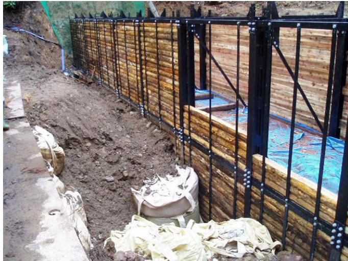
写真 1.16 下流側に設置した壁材（角材）
