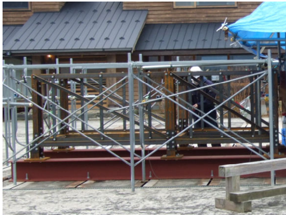
①鋼製枠を組み立てる
