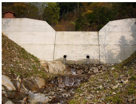
(b) 型枠撤去タイプ（型枠なし）
