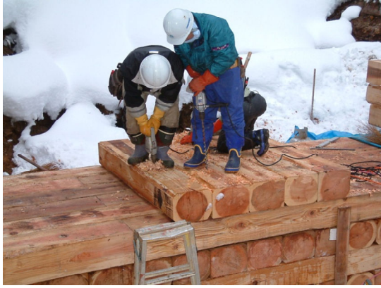
写真 1.14 施工状況と接合具（ラグスクリュー）
