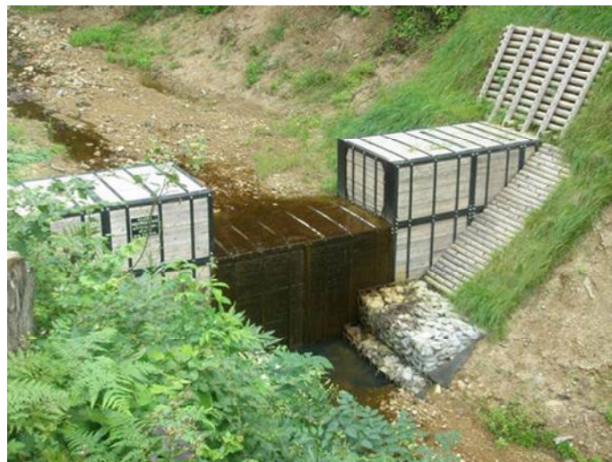
写真 1.15 ハイブリッド型木製治山ダム
