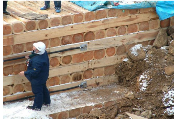
堤体上流側の土圧計、水圧計
