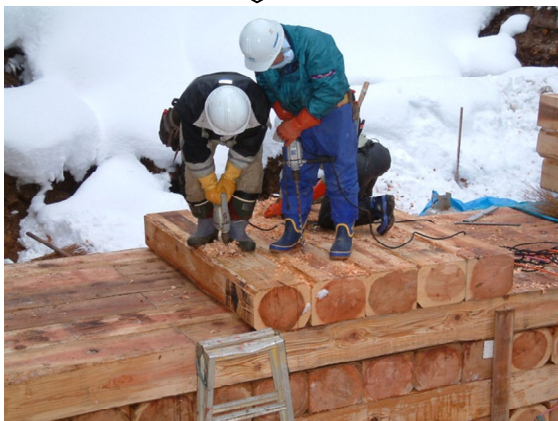
③接合具を打ち込むための先孔あけ (先孔径：φ15mm)
