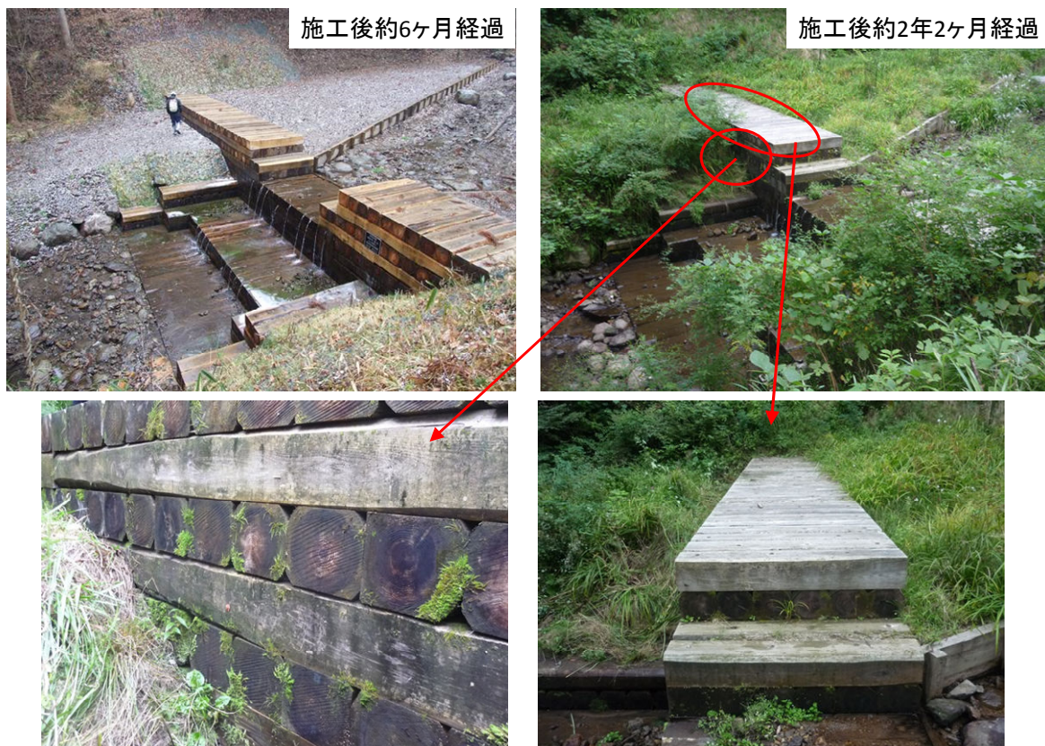
写真 3.11 現地状況（芹原 No.4、経過年数 2.2 年）
