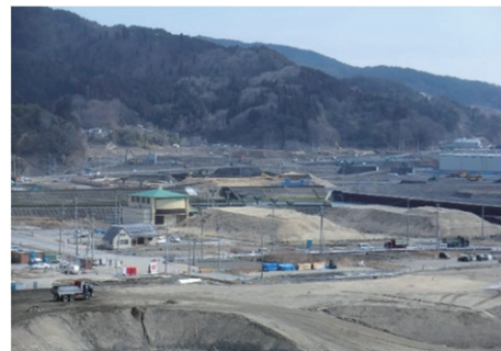
図 8 嵩上げ盛土の造成が進む大槌町町方地区
