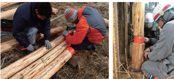
図 12 杭先端および打ち継ぎ部のロードセル
