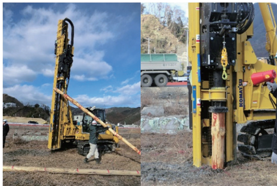
図3 アカマツ杭の打設実演（大槌町）
