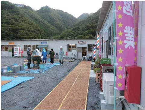
図2 仮設商店街のチップ舗装
