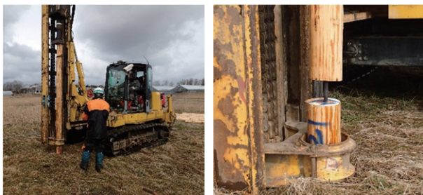
図 11 木杭の打設と打ち継ぎ部
