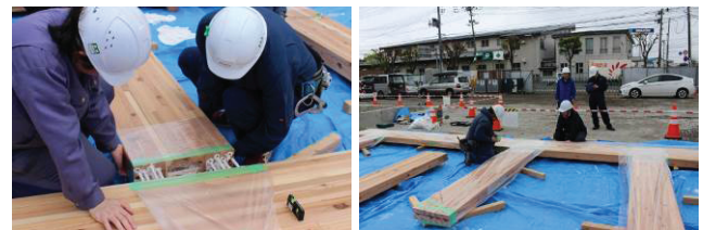
図 7 木ダボ接着接合の接着・養生
