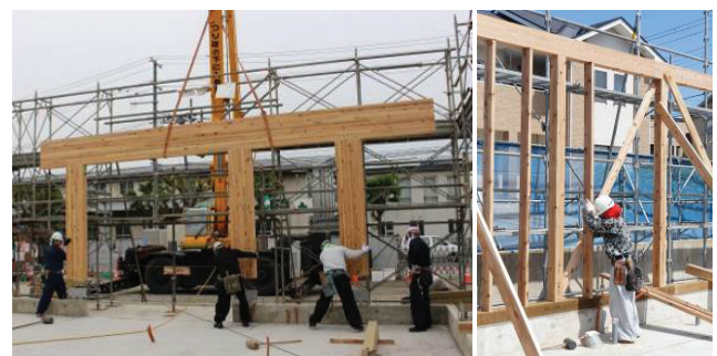
図 8 ラーメンフレーム建方 (左) と在来軸組建方 (右)
