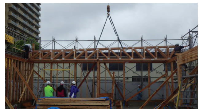
図 9 トラス梁による小屋組の建方
