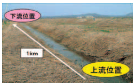
写真2 小排水路の様子
