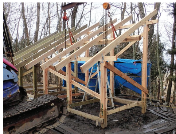
図6 木製基礎に設置した木製架台の載荷試験
