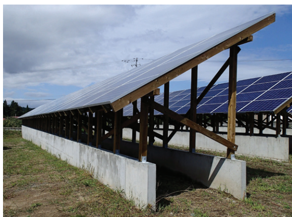
図5 実用化した木製架台（青森県浪岡市） （上：パネル設置前，下：パネル設置後）
