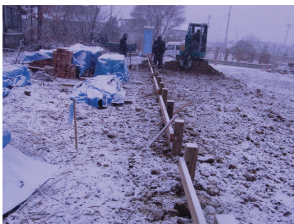
図7 木製基礎の設置
