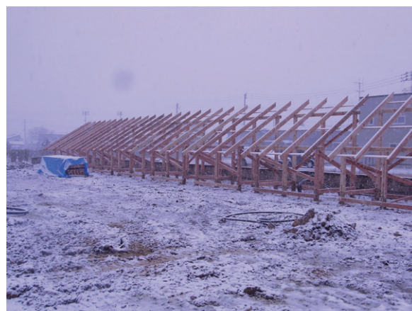
図9 木製基礎と木製架台の設置
