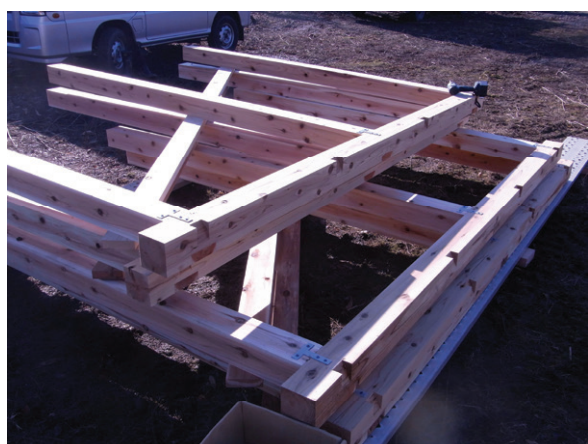
図8 ユニット化した木製架台
