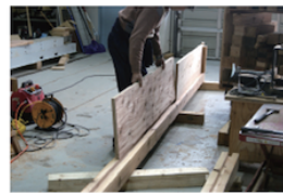
③ 構造用合板 (28mm) を下弦材と束に設けたスリットに差込み
