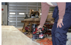
④ CN75 釘で 24mm 構造用合板をフレームに打ち付け
