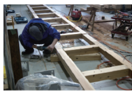
② 接合構造用ビスを下弦材継ぎ手部に 2 本打ち込み
