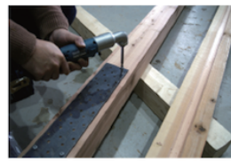
① 上弦材・下弦材の縦継ぎ (仮止め)
