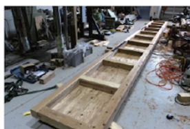
⑥ 片面打ち付け後回転させた状態
