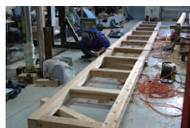
① 縦継ぎした上弦材に束を差しつけてフレームを作成
