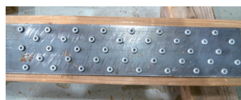
図6 JCL3 プレートによる下弦材の接合
