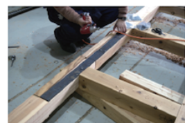
③ 下弦材継ぎ手の両側に JLC1 を取り付け
