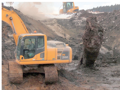
図2 象潟 IC 出口付近の工事で発見された埋没ケヤキと工事の様子
