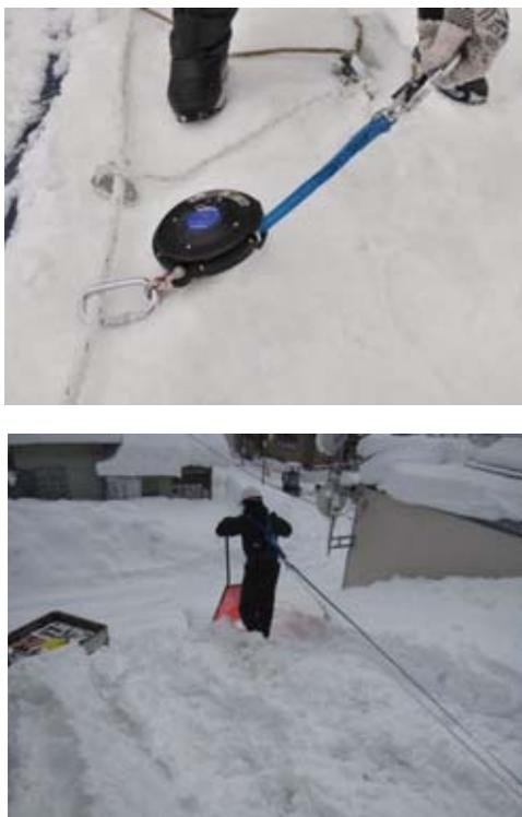
図6 ベルブロックの取付状況.
